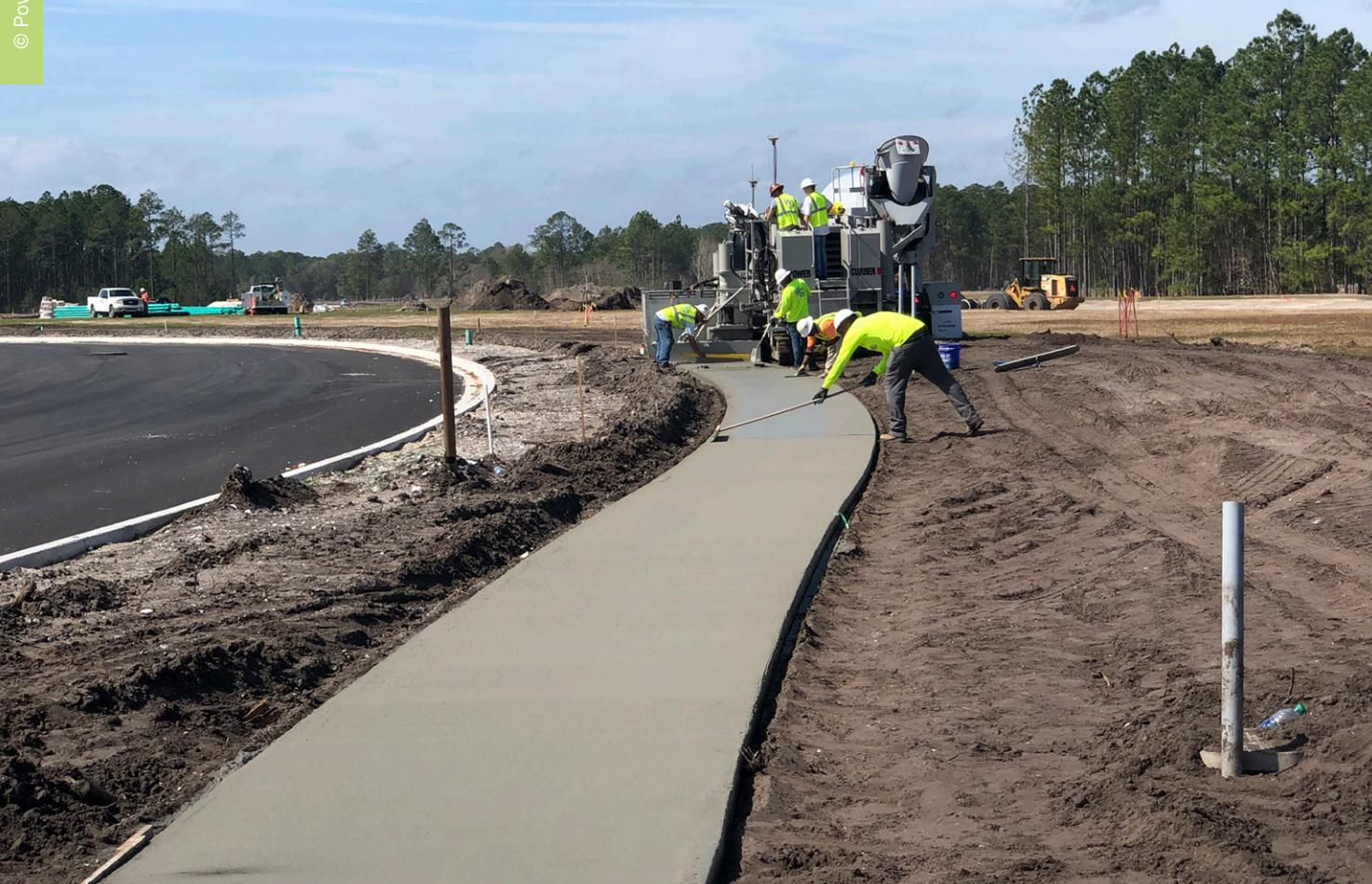
Ergänzend zum neuen Beton-Gleitschalungsfertiger 5700-D entschied sich das Team von 3D Concrete Solutions aufgrund der bekannt hohen Genauigkeit des Systems auf den Erdbewegungsmaschinen von W. Gardner, LLC für das Leica iCON-Maschinensteuerungssystem zum 3D-Betoneinbau.
