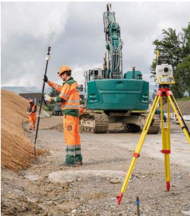
**Abbildung 2:** Arbeiten Sie ohne Dosenlibelle und steigern Sie die Produktivität durch das Messen von Punkten mit einem beliebig geneigten Lotstab.
