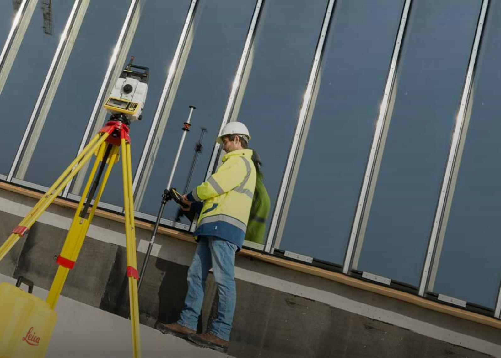
Reichweite und höherer Messgeschwindigkeit sind schwierige Umgebungen kein Grund mehr, das Ziel aus den Augen zu verlieren. Sollte der Strahl durch Kollegen, andere Gewerke oder Baumaschinen unterbrochen werden, wird die Verbindung rasch und automatisch wiederhergestellt.
