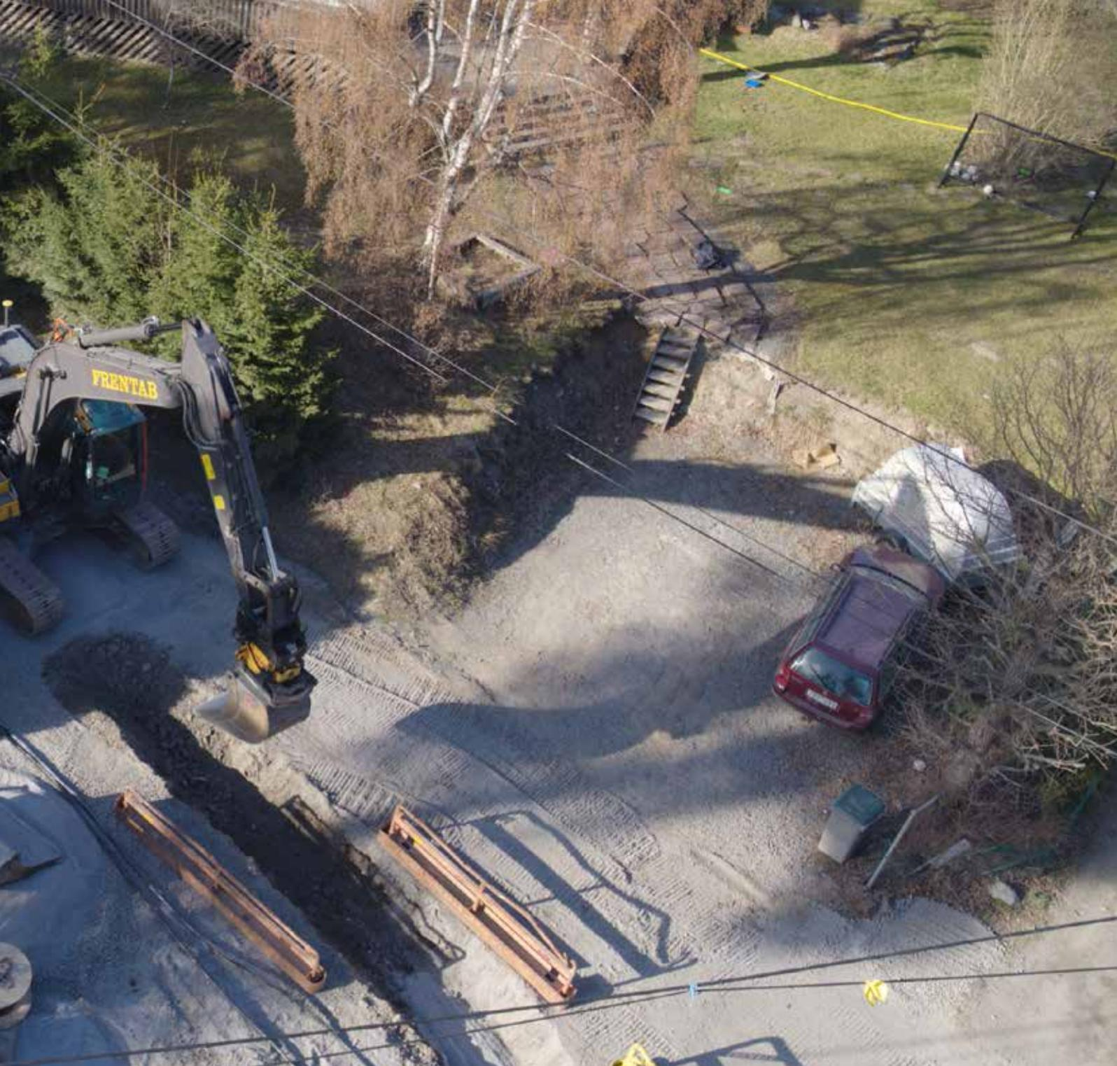
3D-Maschinensteuerung bis auf weiteres nicht möglich. Dann wechselt Jakobsson auf seiner Bedieneinheit in den 2D-Modus, und ein Vermessungstechniker muss ihm die Bezugspunkte einmessen. „Das Problem ist, dass Situationen wie diese heutzutage nicht mehr vorgesehen sind. Es gibt keine Vermesser, die für solche Tätigkeiten auf Abruf bereitstehen. Das bedeutet dann, ich muss warten“, so Jakobsson.
