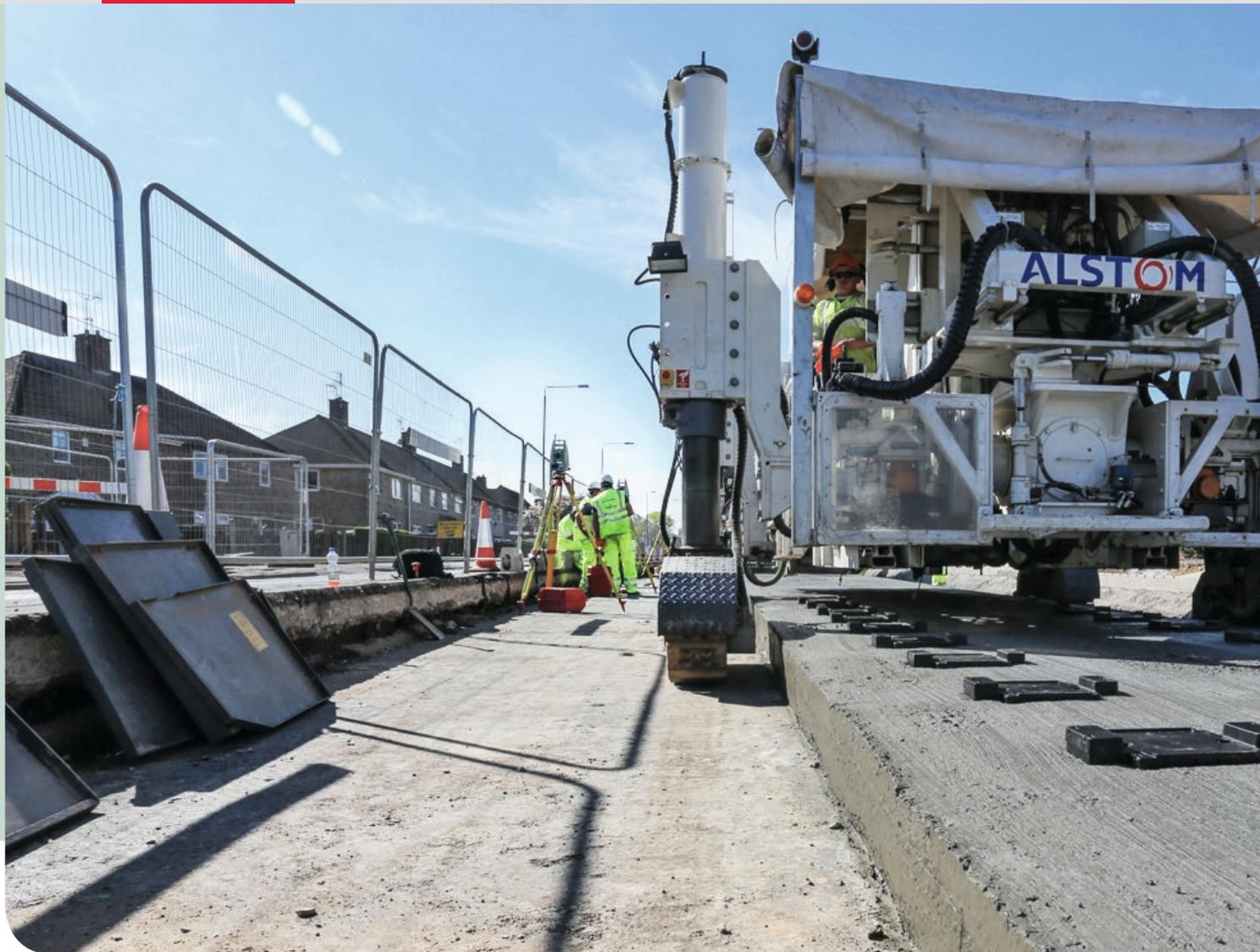
■ Con la ayuda de las estaciones totales Leica Viva TS15 y PaveSmart 3D, Appitrack™ de Alstom asegura una plataforma para el tranvía
