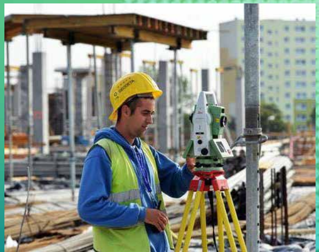
Construcción de un centro comercial, Polonia
