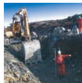
14 Gasleitungsbau in Norwegen
