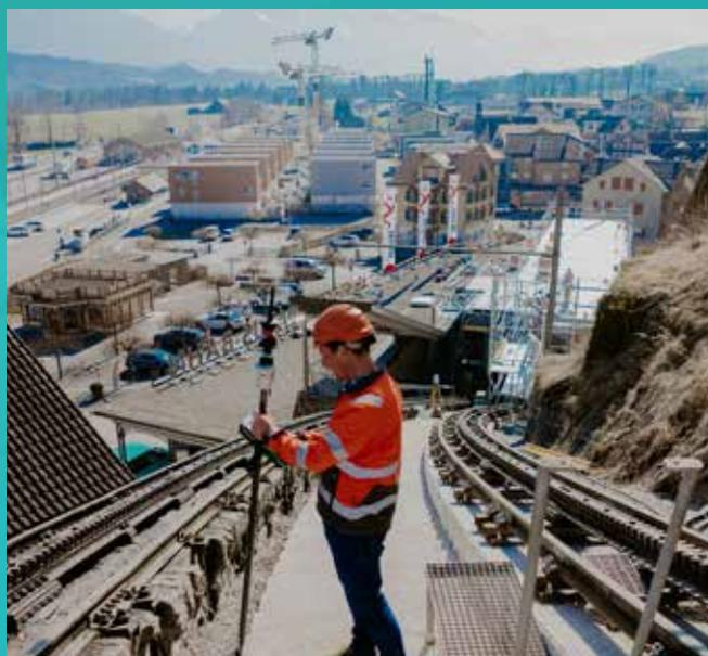
Fabian Nebel, directeur de la construction et des levés d'ingénierie chez Trigonet AG, utilise l'unité Leica AP20 AutoPole pour effectuer des mesures sur le chantier du chemin de fer à crémaillère le plus raide au monde, celui du mont Pilate, à Lucerne, en Suisse.
