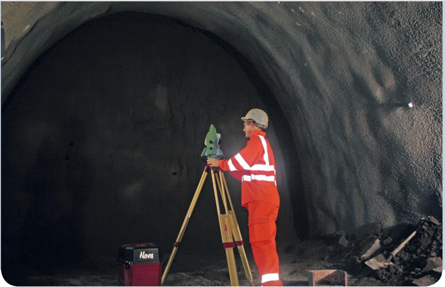
che Auge Ungenauigkeiten an der Form des Tunnels festzustellen. Wir mussten sicherstellen, dass wir die erforderlichen Toleranzen beim Vortrieb erreicht hatten und etwa einen Zentimeter vom fertigen Profil entfernt waren.»
